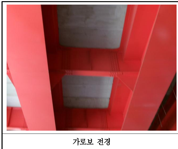
【사진 6.3.28】 가로보 전경
