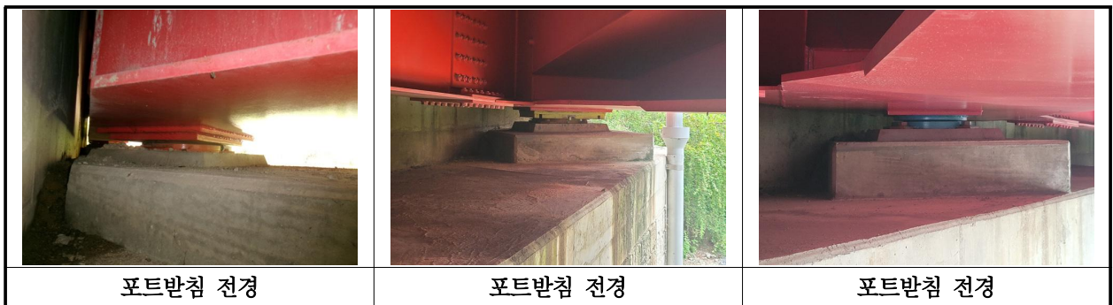
【사진 6.3.10】 교량받침 전경
