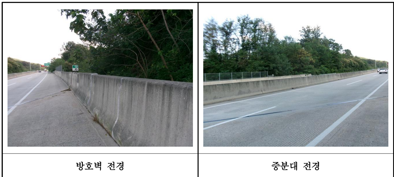
【사진 6.3.43】 방호벽 및 중앙분리대 전경
