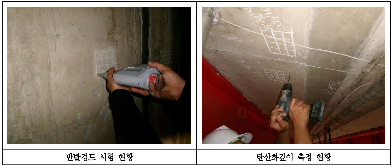
【사진 6.4.1】 콘크리트 내구성조사 현황
