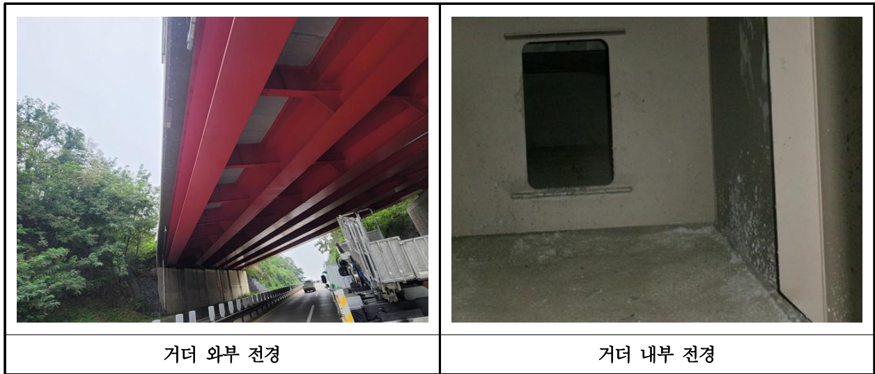
【사진 6.3.4】 거더 전경
