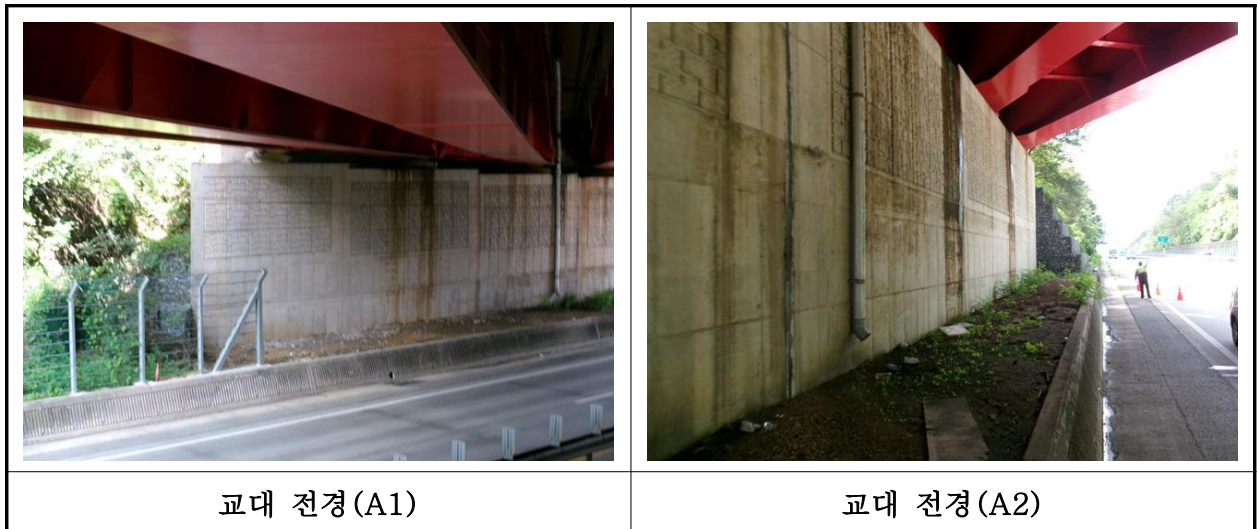
【사진 6.3.30】 교대 전경
