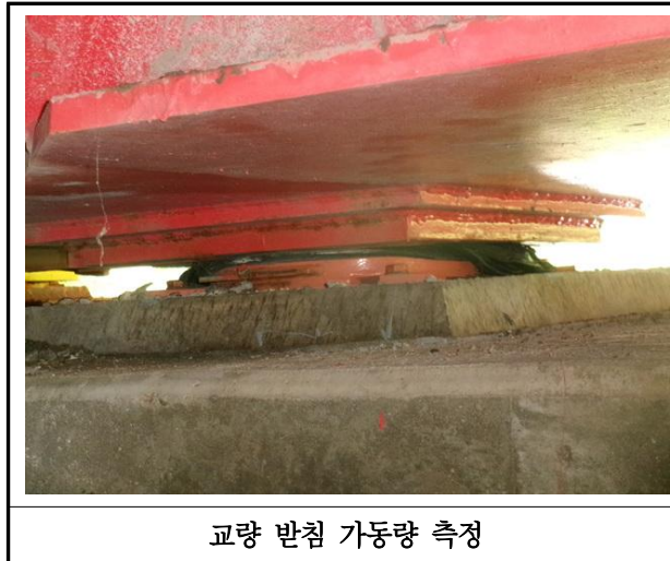
【사진 6.3.35】 교량받침 이동량 측정
