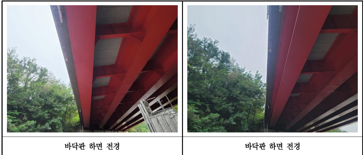
【사진 6.3.2】 바닥판하면 전경
